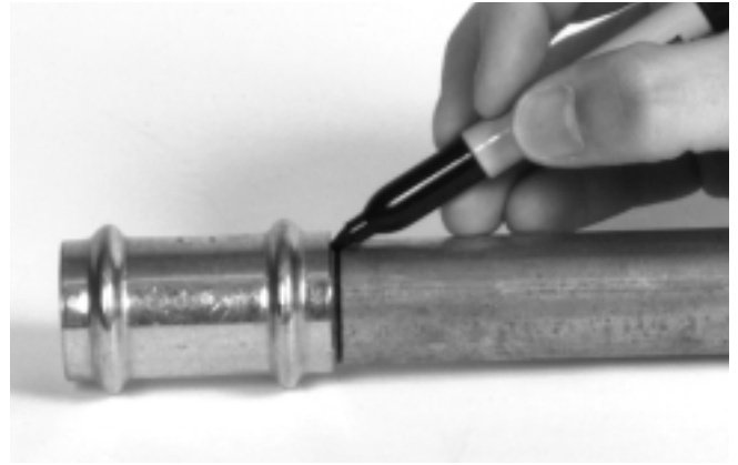
Figure 5 – Marquage du tuyau
